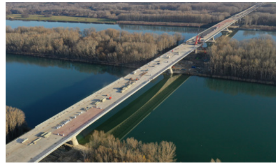
Die fünfte Donaubrücke für Bratislava ist rund 3 km lang und überbrückt neben der Donau auch den Kayak sowie weitere Gewässerarme.
