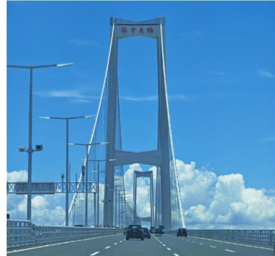
Hauptbrücke des Shenzhong-Link mit 1.666 m Hauptspannweite und dem Brückendeck 91 m über der See.
