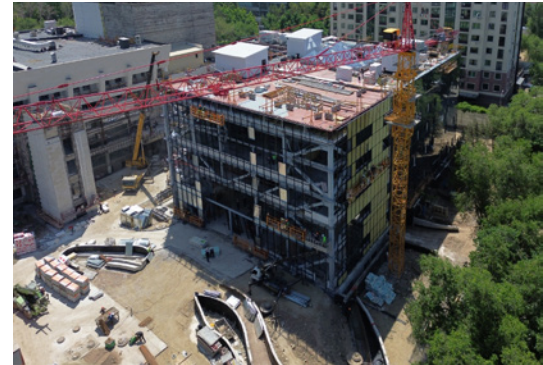
Der Baustellenzustand des Anbaus lässt die SHARKS® an der Frontseite noch erkennen. Die rechte Fassade wird bereits verkleidet, links das Hauptgebäude, das saniert wird.
