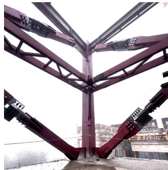
Vier SHARKS® an der Ecke in den oberen beiden Etagen. Rechts SHARK® 2400 kN und links SHARK® 1400 kN.
