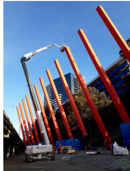
Installation eines neuen Dämpfers.
