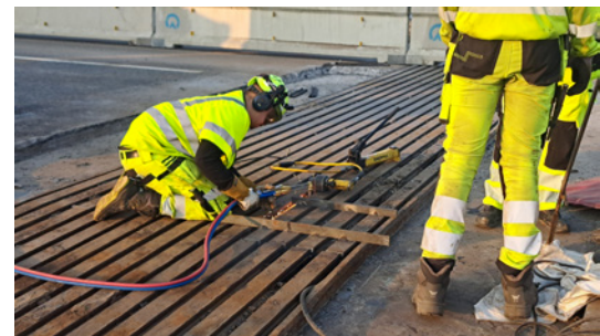
Vorbereitungen zum Ausbau der alten Übergangskonstruktion.
