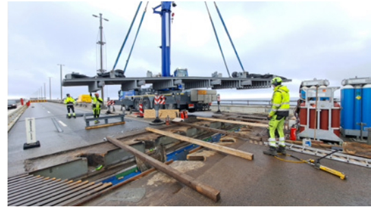
Einbau des mittleren Teils der ersten neuen Übergangskonstruktion. Rechts und links lief der Verkehr weiter.
