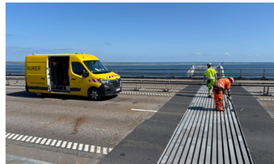
Letzte Arbeiten an der fertigen Übergangskonstruktion.
