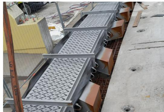
Fahrbahnübergangskonstruktion am Tunnelleingang im Schwebezustand. Gut zu erkennen die aufgeschweißten Rauten für die Geräuschminderung.
