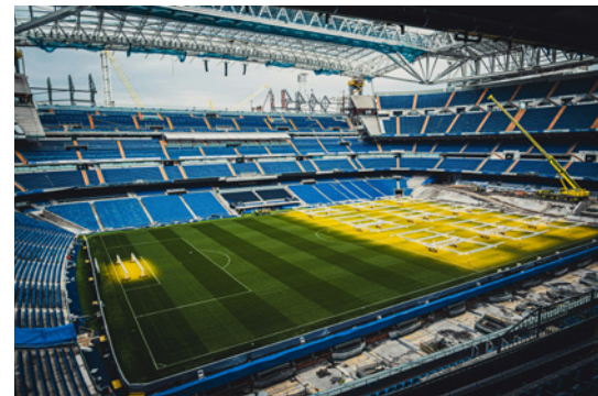
Das Bernabéu im Bauzustand. An den äußeren Ecken der Dachkonstruktion (hinten im Bild) liegen die vier Lager mit einer Auflast von je 67 MN.
