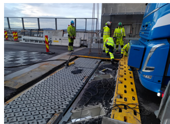
Eingehobenes Mittelträgerpaket, links mit Stahlschluss, rechts eingepasst in die alten, aber ebenfalls sanierten, Traversenkästen.
