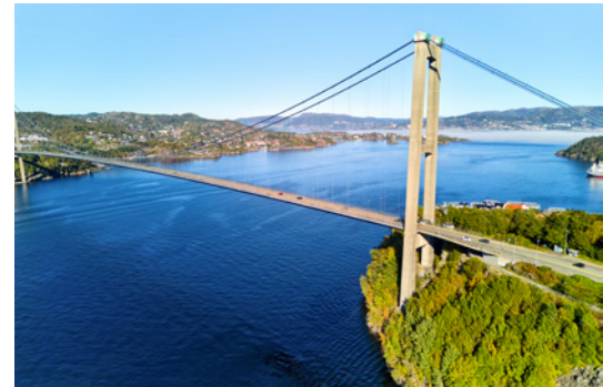
Die Askøy-Brücke im Südwesten Norwegens hat eine Hauptspannweite von 850 m.
