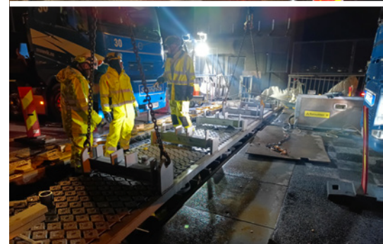
Einhub des neuen Mittelträgerpakets in der Nacht. Foto: MAURER
