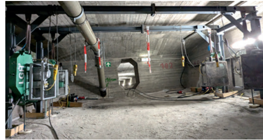
Seilwinden im Brückenhohlkasten.
