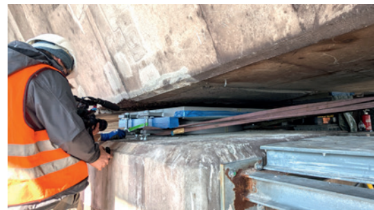
Neues eingeschobenes Lager.
