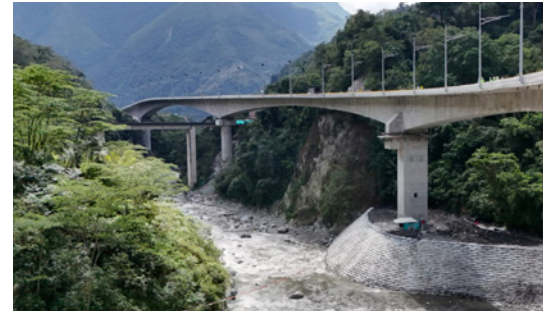
Die K58-Brücke in Kolumbien.
