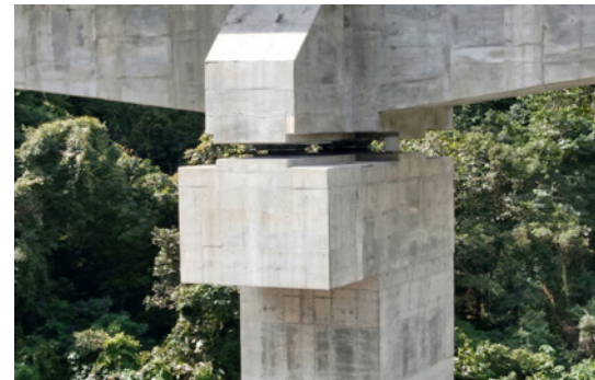
Eingebaute Lager auf einem der Pfeiler.
