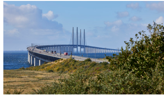
The Øresund Bridge.
