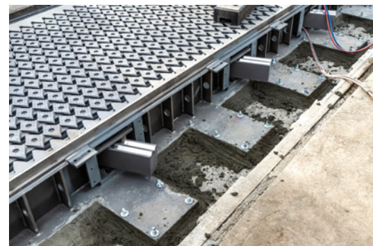
Die Üko an Ort und Stelle. Gut sichtbar die Traversen mit den glänzenden Katamaranlagern in W-Form. Sie tragen die Lamellen (quer zur Fahrbahnrichtung) mit den Lärmschutzrauten.
