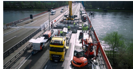
Links die neue Üko unter Verkehr, die am vorhergehenden Wochenende ausgetauscht worden war, rechts die Lücke nach dem Ausbau des alten Rollverschlusses.
