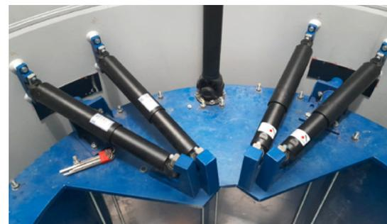
Innen eingebaute hydraulische Dämpfer an der blauen Dämpfermasse, um die Massenbewegung abzubremsen und zu begrenzen.
