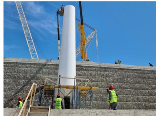
Die Schwingungsdämpfer wurden Teil für Teil in das Segment 9 des Fahnenmasts eingehoben und montiert, bevor das komplette Segment auf den Mast gesetzt wurde.
