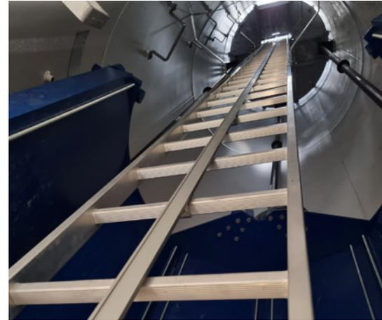
Der unterste der drei Schwingungsdämpfer: Blau die Masse in Form eines Dreiviertelzylinders; rechts, hinter der Leiter und am linken Rand der Leiter sind die drei Pendelstangen erkennbar.
