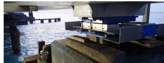
Die Speziallager SIP®-FZ. Sie werden beim Heben der Brücke geöffnet (Z = Zug) und rückzentrieren sich beim Schließen aufgrund ihrer Geometrie und spezieller Federn (= F).
