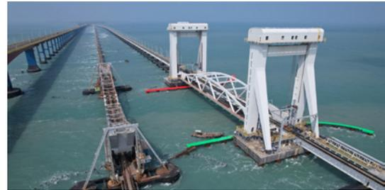
Die drei Pamban-Brücken: In der Mitte die stillgelegte Eisenbahn-Klappbrücke, rechts die neue Eisenbahn-Hubbrücke, links die Straßenbrücke.
