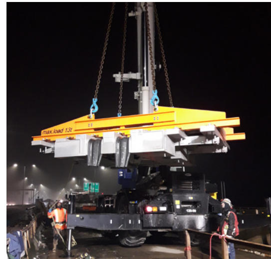
Einbau der ersten Wanderschwelle in Montreal im November 2020.
