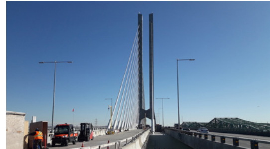
Die im Bau befindliche Mittelbrücke, eine Bahnbrücke, führt durch das charakteristische Pylonenpaar der Neuen Champlain-Brücke. Rechts fließt bereits seit drei Jahren der vierspurige Straßenverkehr.
