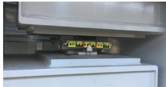
Die Dachträger liegen seitlich auf Kalottenlagern. Für die ursprünglich geplanten Elastomerlager reichte der Platz nicht.
