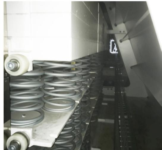
Blick in die „Tiefe“ – sprich: Länge – der Dachträger. Oben im Bild die langgestreckte schwingende Masse, unten die Federpakete, die individuell auf die Frequenzen der Träger justiert wurden. Die Schräge rechts resultiert aus der Geometrie der Stahlkastenträger. Das Licht in der Bildmitte rechts zeigt den nächsten Einstieg.
