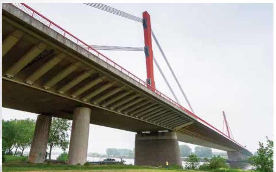
Die beiden Stahlpylone der Schrägseilbrücke haben eine Höhe von 66,7 m und stehen in der Brückenmittelachse. In den Pylonen sind je Fahrbahnseite drei harfenförmig angeordnete Seilgruppen verankert.
