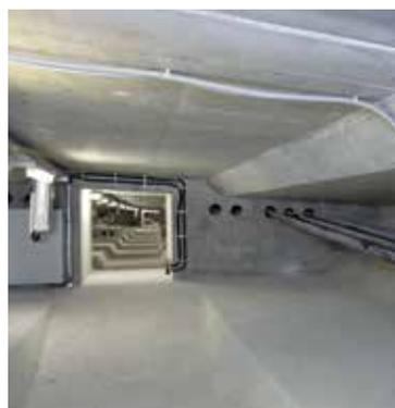
Instrumentiertes Lager an der Achse 40 **Rechts:** Blick in den Hohlkasten der Brücke, im Vordergrund Sensorkabel
