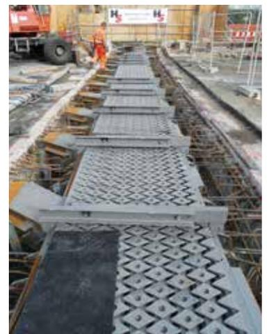
Die neuen Fugen sind geräuschgemindert. Beim Befahren der Übergangskonstruktionen hört man keinen Unterschied zum Straßenbelag.
