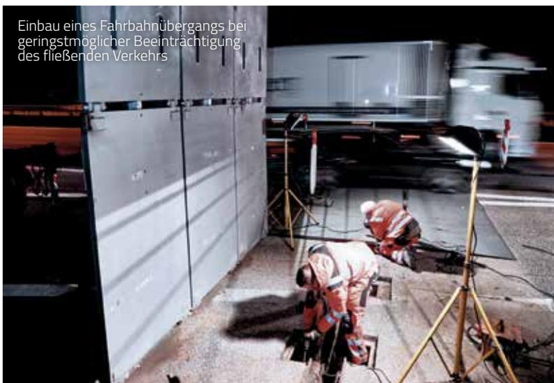
Einbau eines Fahrbahnübergangs bei geringstmöglicher Beeinträchtigung des fließenden Verkehrs
