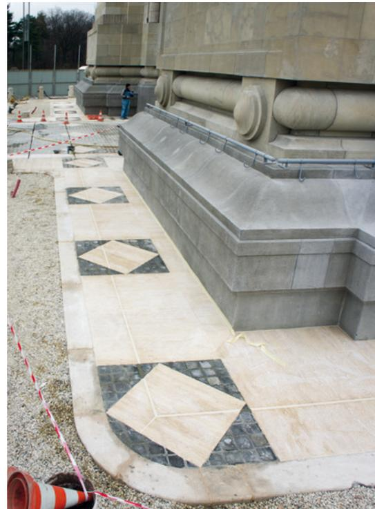
Die Dehnfuge integriert sich im Endzustand nahezu unsichtbar in die Gestaltung. Lediglich die Fugennähte am Eck lassen ahnen, dass sich darunter etwas verbirgt
