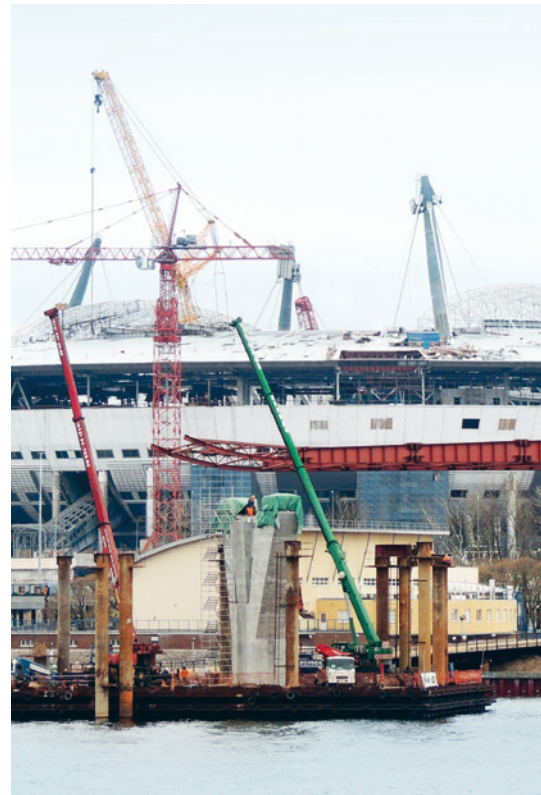
Baustelle Zenit-Stadion direkt an der Newamündung: Trotz des Gewirrs der Kräne deutlich zu erkennen sind die acht Pylone.
