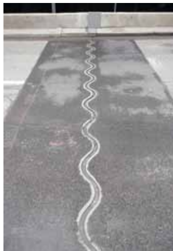
12 Wellenförmiger Fahrbahnübergang mit einem Dichtprofil © Maurer Söhne GmbH & Co. KG
