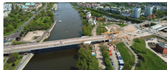
Die Neue Strombrücke über die Elbe in Magdeburg während der Sanierung 2023. Rechts die 2. der insgesamt 3 Brücken des Brückenzugs.
