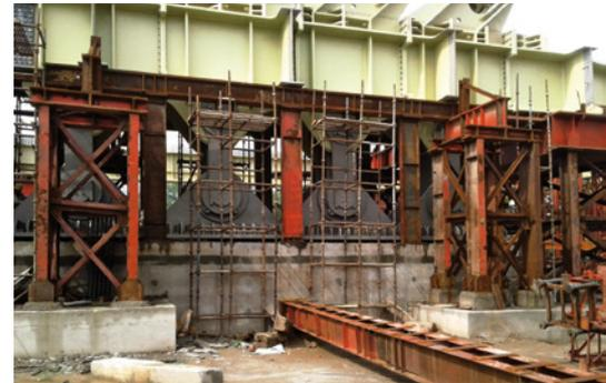
Die Pendellager (grau) nehmen die Zugkräfte der Rückhalteseile auf (Verankerung am oberen rechten Bildrand erkennbar) und erlauben die Längsbewegung des Brückendecks (lindgrün).
