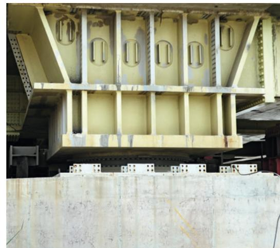
Das größte je gefertigte MSM®-Kalottenlager mit einer Auflast von bis zu 231.000 kN unter einem der beiden Pylonfüße.
