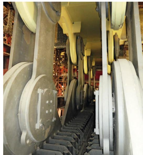
Die Pendellager-Paare in Längsrichtung der Brücke gesehen. Außen jeweils die beiden Stahllaschen, oben und unten die Gelenkaugen mit den Axialgelenklagern.
