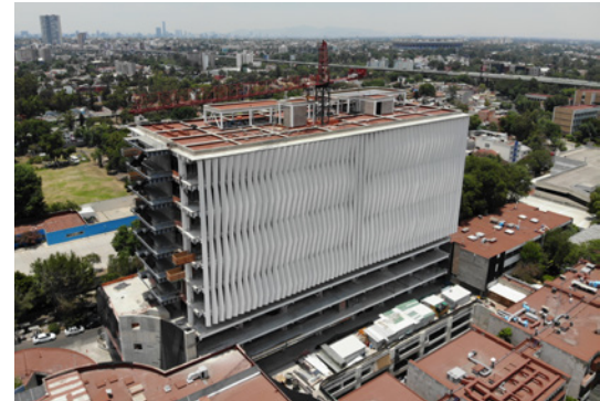
Das Nationale Institut der Medizin- und Nahrungswissenschaften im Süden von Mexiko-Stadt (INCMNSZ) ragt schmal und hoch aus der umliegenden Bebauung hervor. Bauzustand im Mai 2023.
