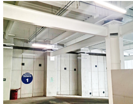
Vier der insgesamt 34 eingebauten SIP®-A-Lager oben auf den Stützsäulen. Unten sichtbar die Abfahrt zum unterirdischen Parkhaus.
