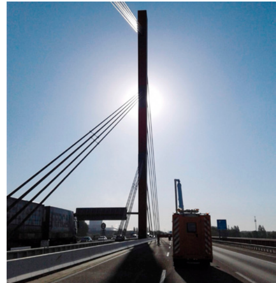
Zwei 66,7 m hohe Stahlpylone tragen die Hauptlast der Rheinbrücke Baerl. Verkehrsführung 4 + 0: Links vier Fahrspuren, rechts komplett gesperrt.
