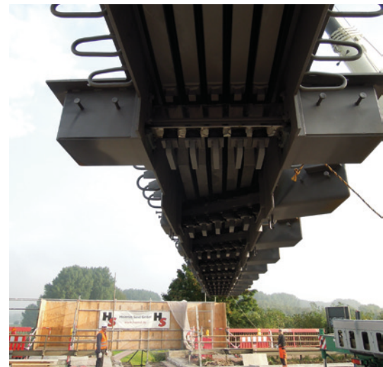
Einheben einer Dehnfuge mit einem 100-t-Kran.
