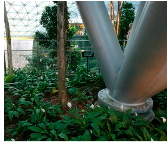
Seltener Anblick: Ein Kalottenlager im Grünen.
