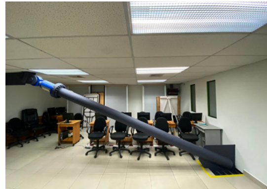
Eingebauter Hydraulikdämpfer: Oben mit Anschluss an die bestehende Gebäudestruktur ...
