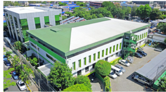
Das „Edificio Napoleon Bolaños Melendez“ in San Salvador wurde in den 1970er Jahren errichtet und nun nachträglich mit hydraulischen Dämpfern zum Erdbebenschutz nachgerüstet.
