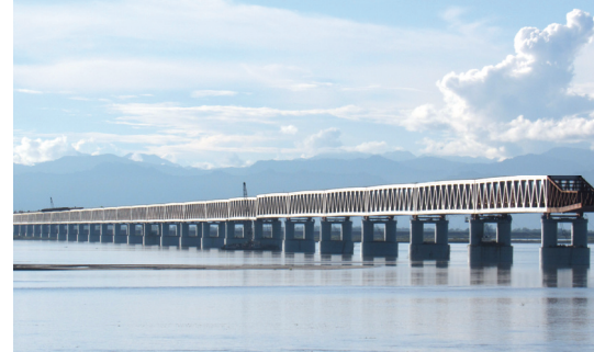
Die Bogibil-Brücke über den Brahmaputra, am Fuß des Himalaya. Das Foto entstand 2017 im Bau.
