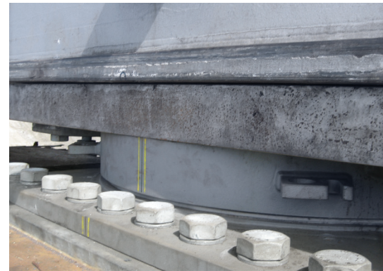
Die Auflager unter der Bogibil-Brücke übertragen auf kleinstem Raum 2.800 t Last.
