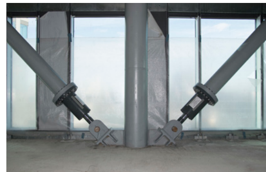
Die Dämpfer sitzen am unteren Ende der Querstreben. Sie sind 750 mm lang.
