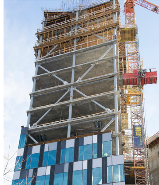
Das Gebäude 2017: Gut erkennbar die diagonalen Streben der äußeren Stahlstruktur, die sich über je zwei Stockwerke ziehen.
