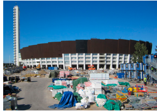
Olympiastadion Helsinki mit Baustellenlager vor der denkmalgeschützten und renovierten Fassade.
