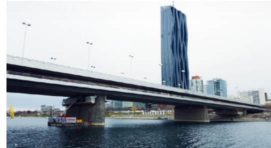
Pfeiler P7 der Reichsbrücke in Wien während der Lagertauscharbeiten. Im Hintergrund der 220 m hohe Donau City Tower 1 mit einzigartigen semiaktiven Schwingungsdämpfern, die sich dem jeweiligen Lastfall anpassen – ebenfalls von MAURER.
