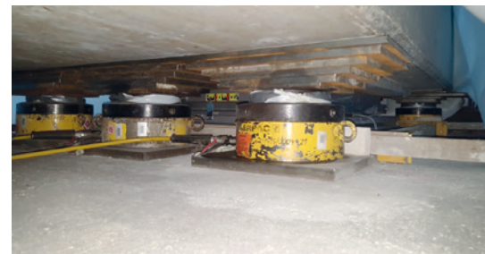
Extrem enge Bedingungen herrschten am Pfeiler P7 der Reichsbrücke in Wien, wo die Lager ausgetauscht werden mussten.
