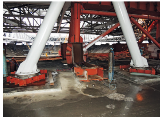
Insgesamt 60 Druck-Zug-Kalottenlager wurden unter der Tribüne verbaut. Bereits für den Bauzustand und auch den Endzustand waren Zuglasten von -3,5 MN zu berücksichtigen.
