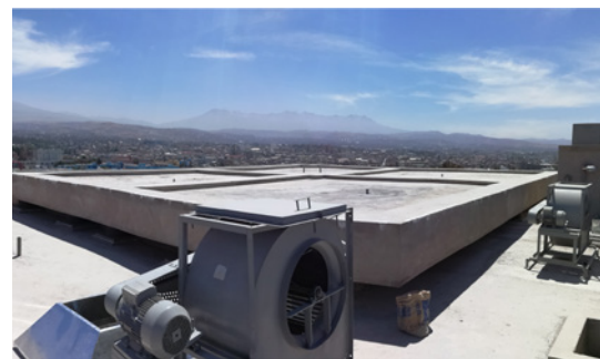
Die Masseplatte als Teil des Daches. Foto: MAURER
