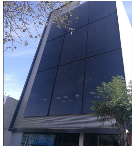
Das neue 9-stöckige Bürogebäude des Versicherungsmaklerunternehmens Consejeros in Peru ist schlank, unsymmetrisch und weich gebaut.
