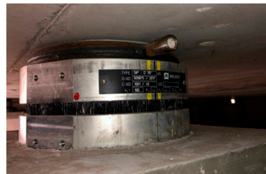
Eines der Doppelpendellager, Typ SIP®-D: Sie haben oben und unten eine gekrümmte Gleitfläche.
