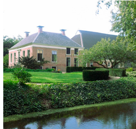
Das sanierte holländische Bauernhaus steht komplett auf Erdbebenisolatoren.
