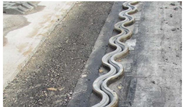
Abb. 1 - Fertige Abdichtung vor dem Schutzschichteinbau
