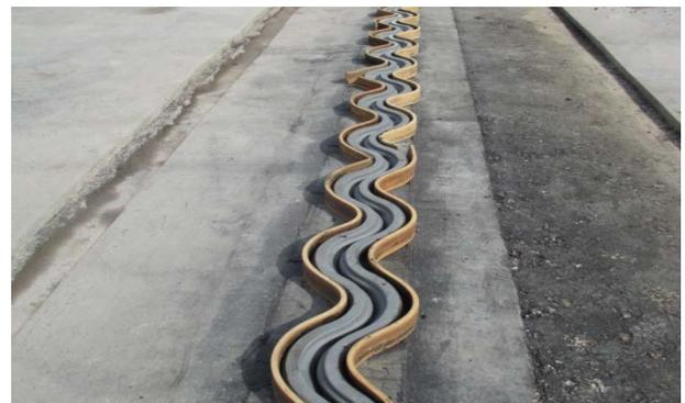
Abb. 2 - Schaumstoff-Abstellung vor dem Gussasphalteinbau
