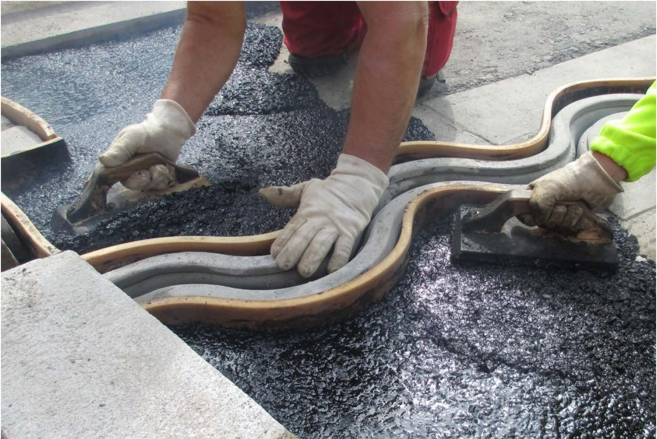
MAURER XW1-Wellen-Dehnfuge - Einbau der Gussasphaltschutzschicht
