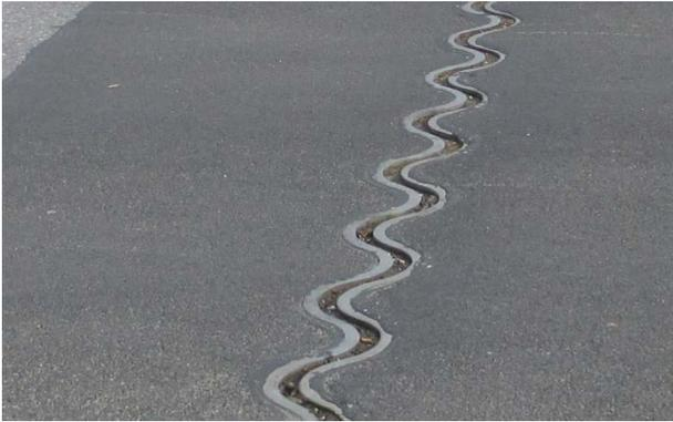
Abb. 5 - Fertiger Asphaltanschluss nach Fugenverguss
