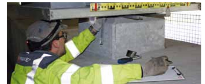
Inspección de los apoyos de un puente
