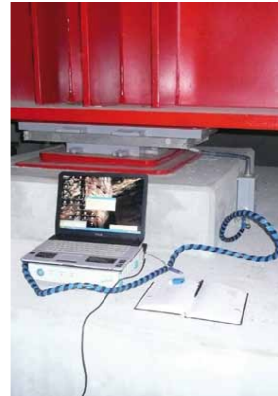
Apoyos MAURER con medición de carga
