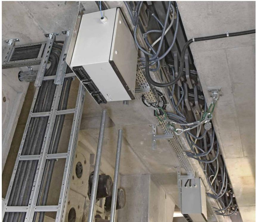
instrumentierte Dehnfuge, Untersicht
