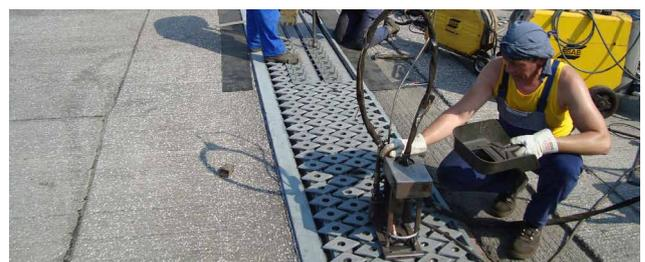
verschweißen der Rauten mit Roboter
