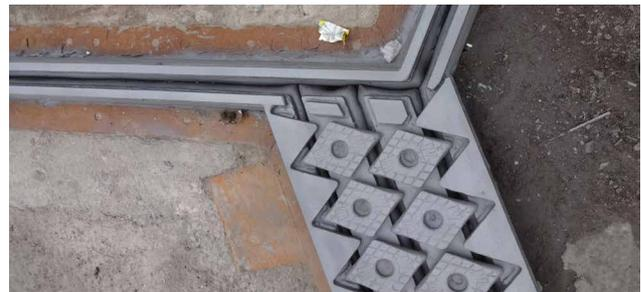
Anschlüsse zwischen Längs- und Quertugen mittels vulkanisierten Formteilen
