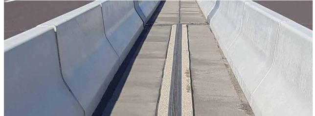
Herstellung der Längsfuge bei getrennten Überbauten
