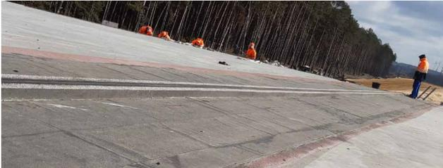
Kompaktfuge mit Betoflex®-Verankerung als Längsfuge zwischen zwei Überbauten
