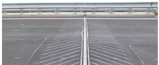
D1 mit stabilisierenden Stützrippen aus Betoflex®
