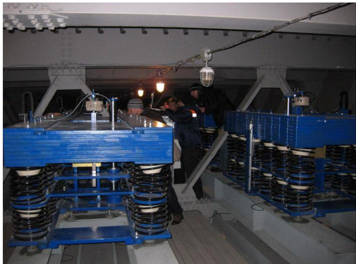
Abb. 21 – Frequenzabstimmungstests an der Universität der Bundeswehr München am *controlledTMD* der Wolgograd-Brücke und finale Aufschwingversuche an den in der Wolgograd-Brücke eingebauten *controlledTMDs*
