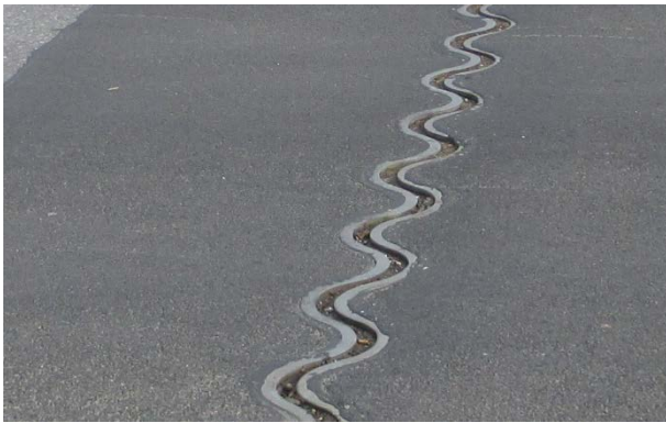
Abb. 5 - Fertiger Asphaltanschluss nach Fugenverguss
