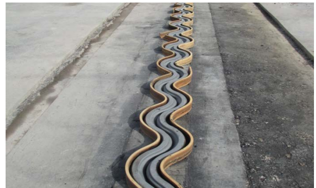
Abb. 2 – Schaumstoff- Abstellung vor dem Gussasphalteinbau
