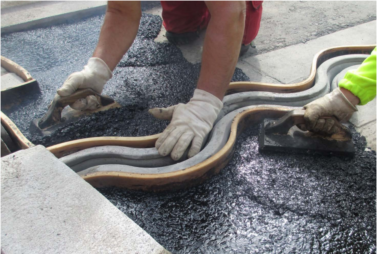
MAURER XW1-Wellen-Dehnfuge - Einbau der Gussasphaltschutzschicht
