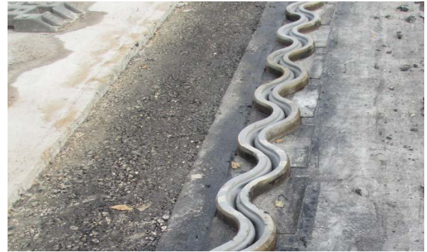
Abb. 1 - Fertige Abdichtung vor dem Schutzschichteinbau
