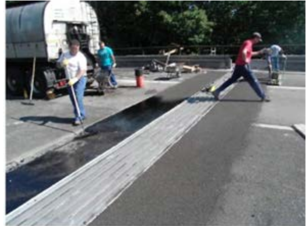
Abb. 9 - Einbau Gussasphalt
