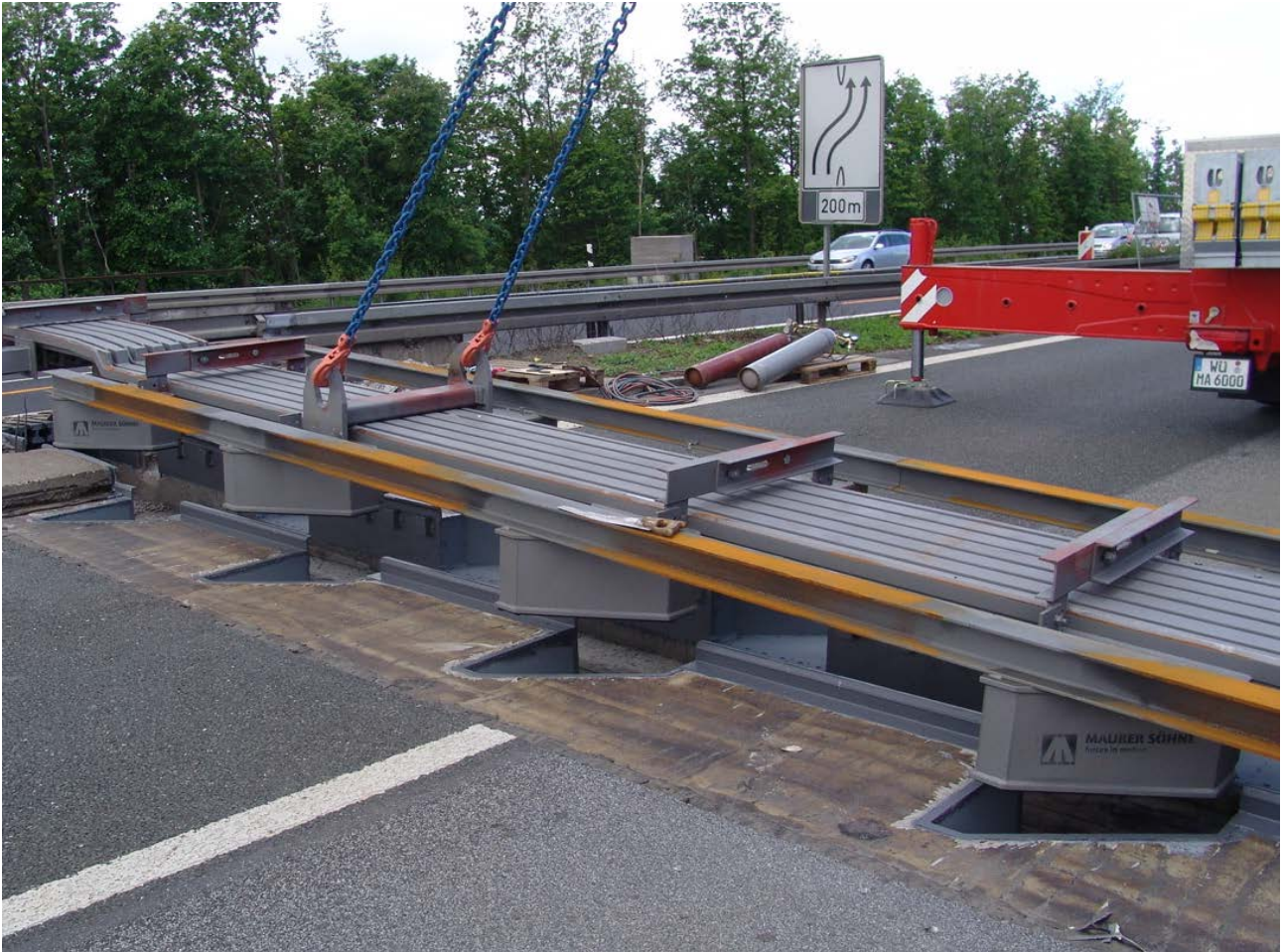
MAURER Dehnfugensanierung System „Kasten-In-Kasten“ - Einhub der neuen Dehnfuge in den vorbereiteten Bestand
