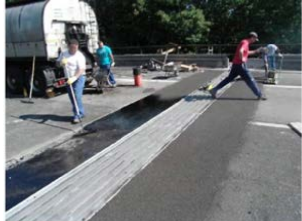
Abb. 9 - Einbau Gussasphalt
