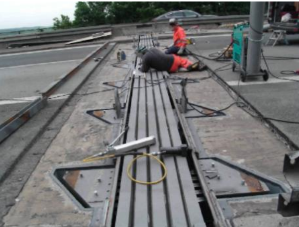
Abb. 8 - Einschweißen der neuen Konstruktion in den Bestand
