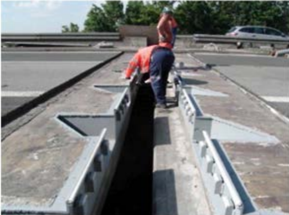
Abb. 7 - Neuer Korrosionsschutz der verbleibenden Konstruktion
