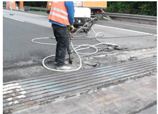
Abb. 5 - Entfernen von Deckschicht, Schutzschicht, Abdichtung
