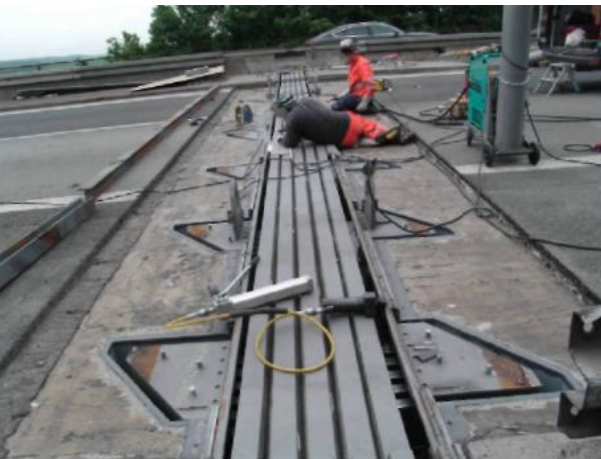
Abb. 8 - Einschweißen der neuen Konstruktion in den Bestand
