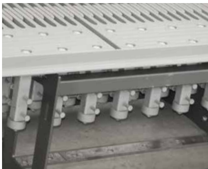
Definiert vorgespannte Fingerfuge (FP)
