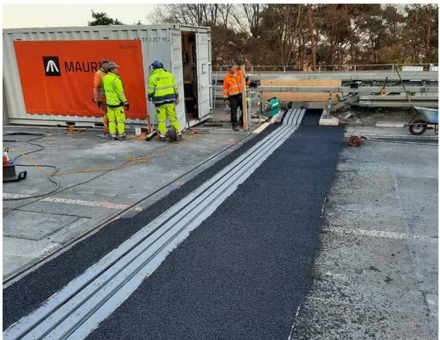
50 Stunden nach Beginn der Baustelle
