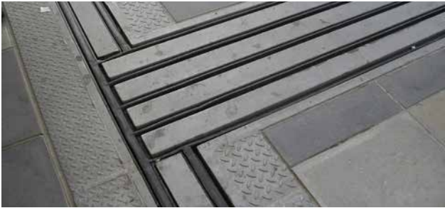
Anschlüsse zwischen Längs- und Querfugen mittels vulkanisierten Formteilen
