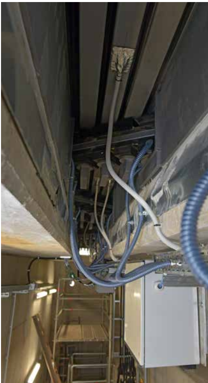
instrumentierte Dehnfuge, Untersicht
