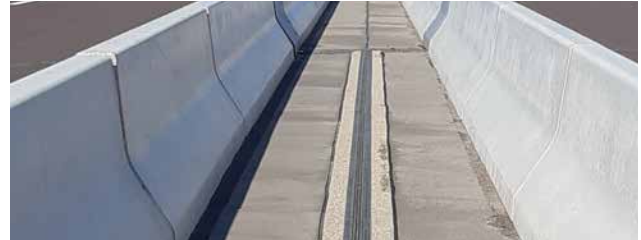
Herstellung der Längsfuge bei getrennten Überbauten
