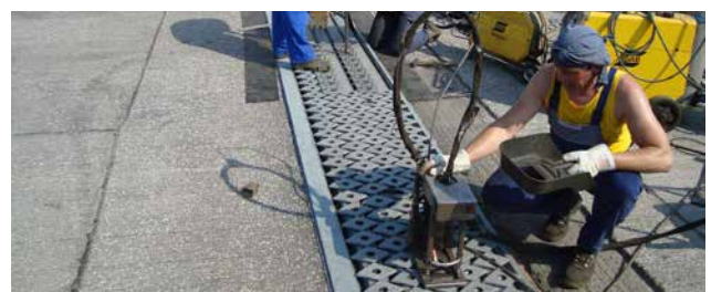
verschweißen der Rauten mit Roboter
