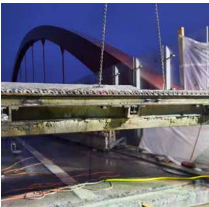
herausgesägte Dehnfuge inkl. Konsolbeton
