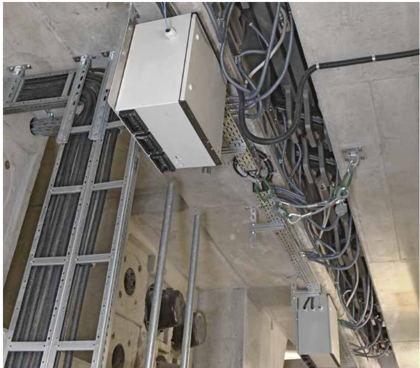
instrumentierte Dehnfuge, Untersicht
