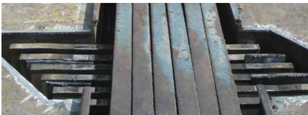
Ausbau der beweglichen Bestandteile
