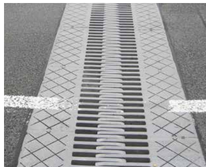
Verschweißte Fingerfuge (FW)
