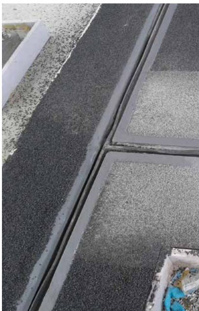
T-Stoß D1 mit Betoflex®
