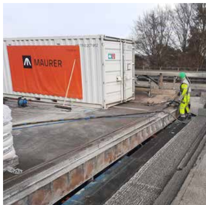
vorbereitete Aussparung für die neue Dehnfuge
