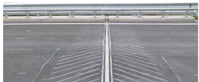
D1 mit stabilisierenden Stützrippen aus Betoflex®
