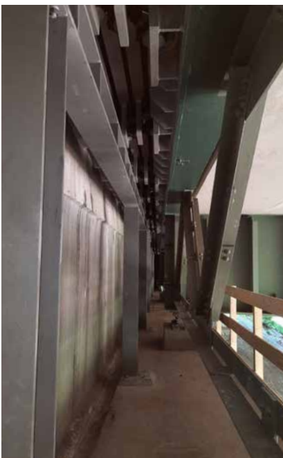
Jochträger für den direkten Lastabtrag
