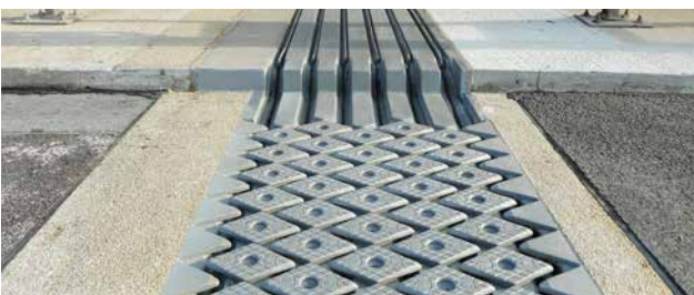
angrenzender Übergangsbalken bei XD6 mittels Betoflex®
