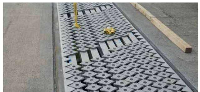
Einbau neuer Mittelträger
