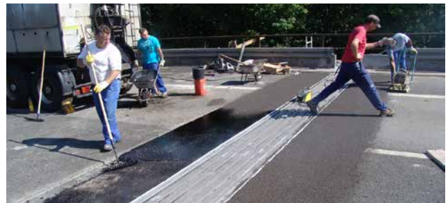
Wiederherstellung Abdichtung / Belag
