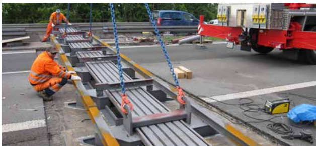
Einheben der neuen Dehnfuge in vorh. Kästen
