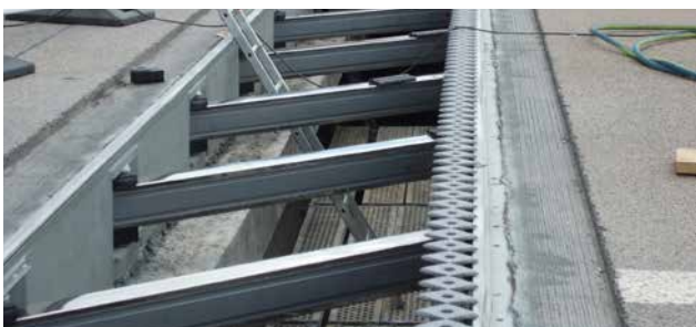
neue Traversen, sanierte Randkonstruktion
