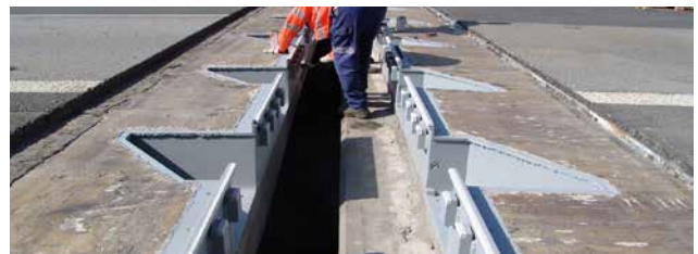
Vorbereitung der verbleibenden Bauteile
